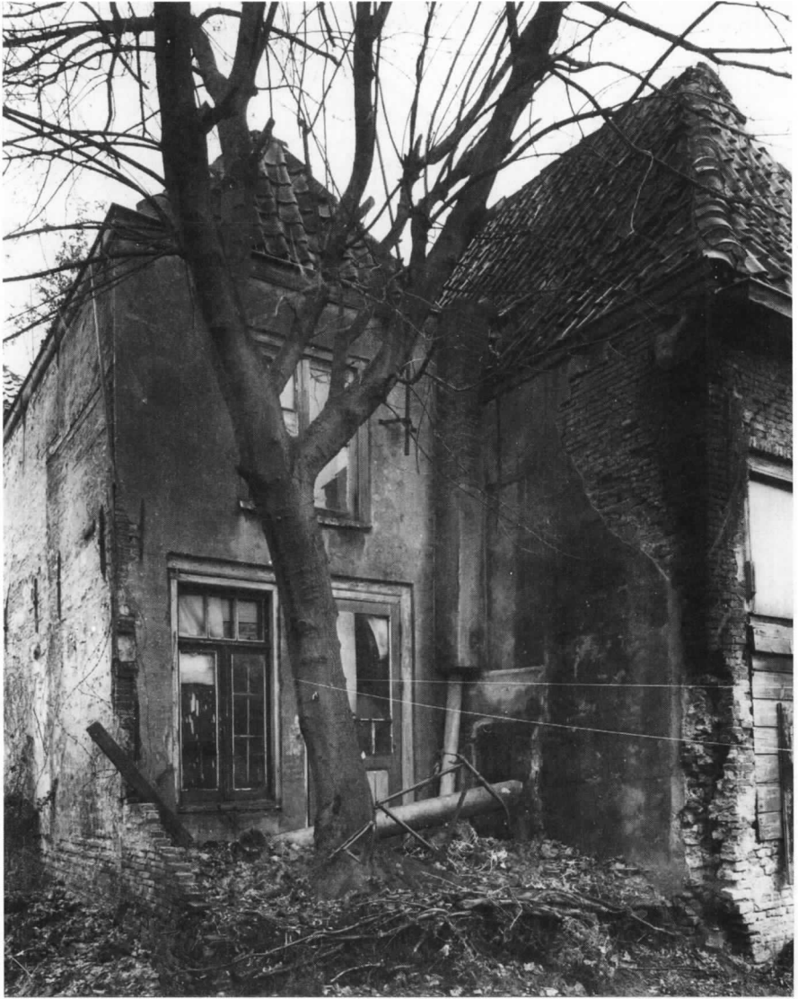
De beide achterhuizen vóór de restauratie. Links de achter Springweg 65 gelegen keuken. (foto Gem. Fotodienst)
