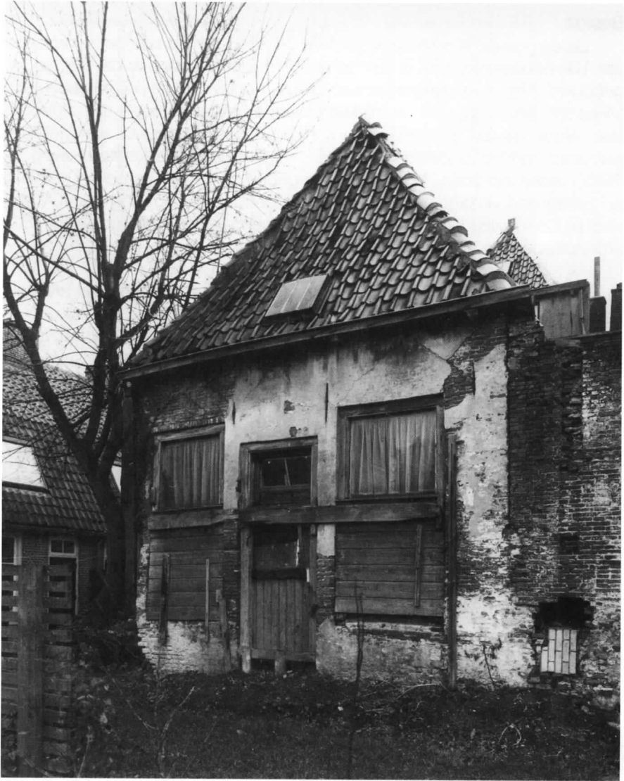
Het achterhuis van Springweg 65, de voormalige timmerwerkplaats, vóór de restauratie. (foto Gem. Fotodienst)
